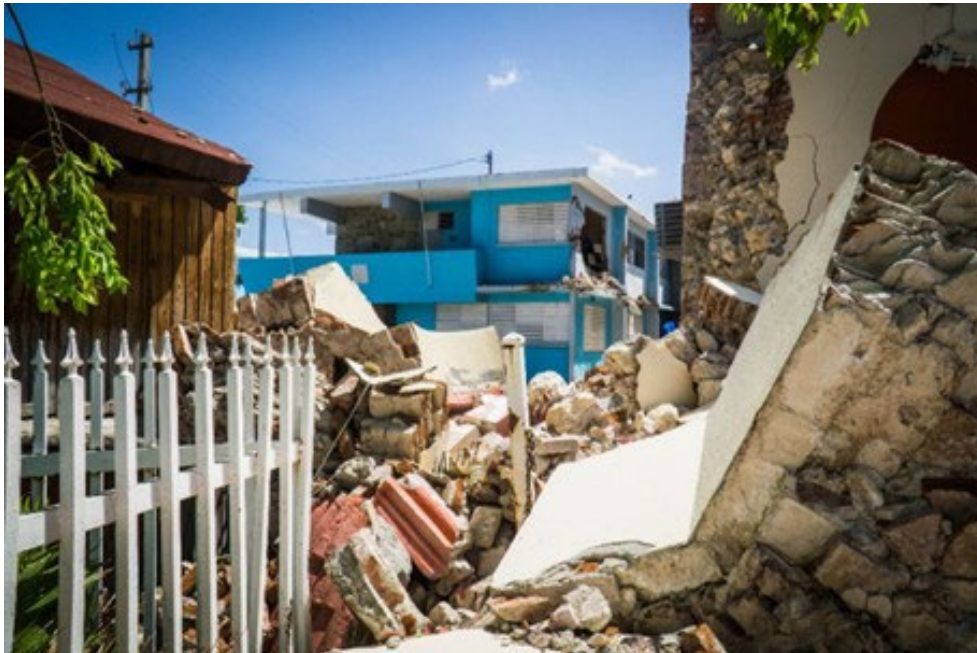
Figura 2: Daños causados por el terremoto de magnitud 6.4 ocurrido el 7 de enero de 2020 in Guayanilla
