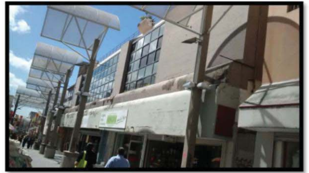
Foto 4: Vista del edificio parte superior.
