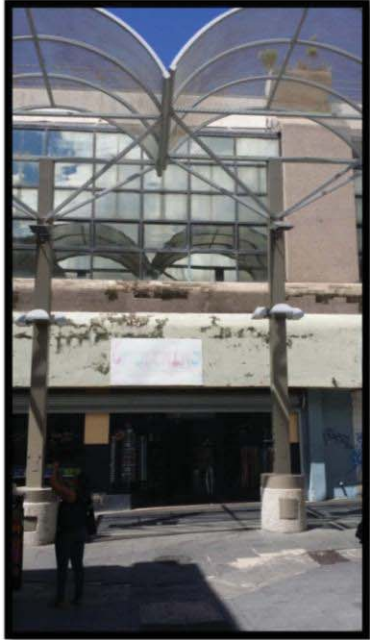
Foto 7: Entrada principal del edificio.
