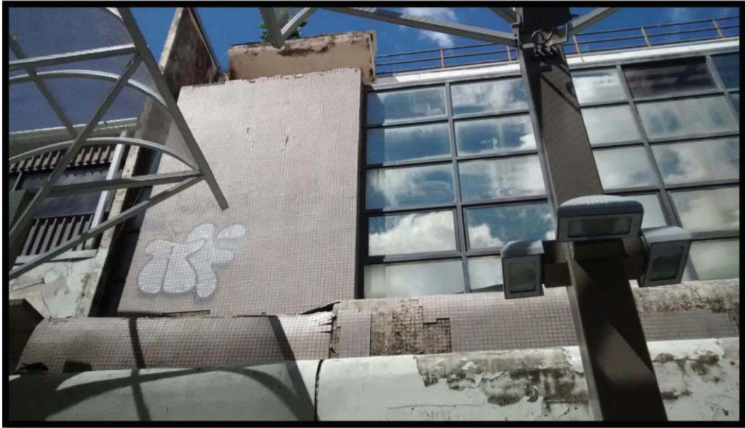
Foto 11: Véase detalle del edificio en su parte superior.
