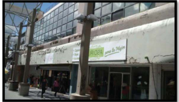
Foto 2: Vista del edificio parte del frente.
