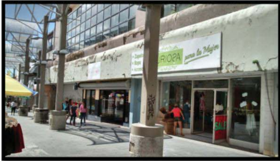
Foto 1: Vista del edificio parte del frente.
