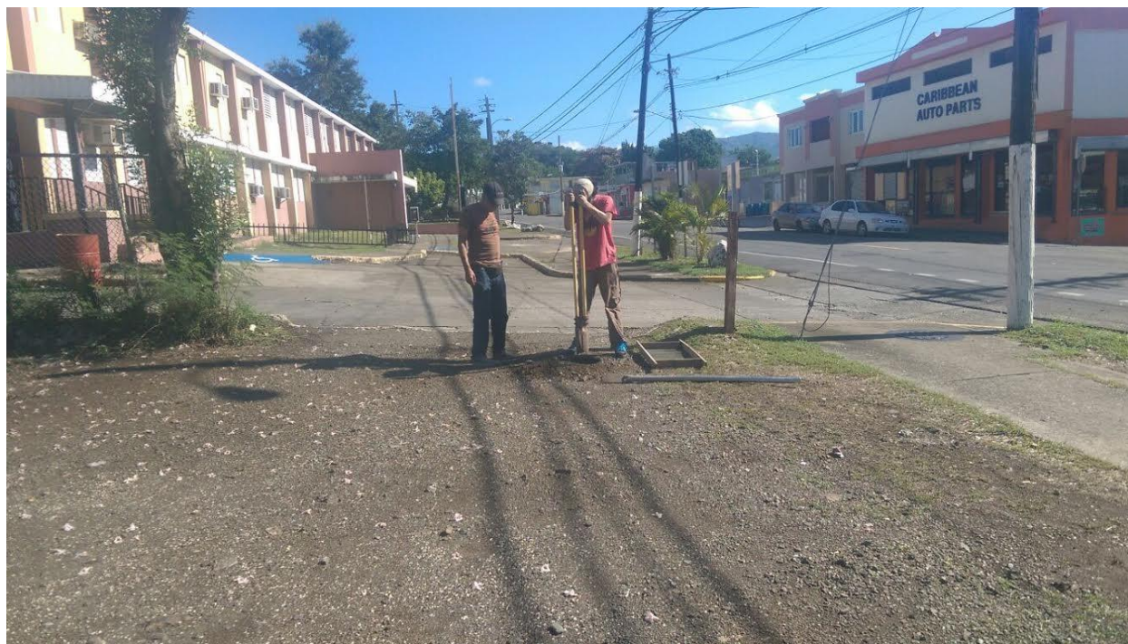
Foto 7: Inicio de los trabajos de campo de la Fase IB.
