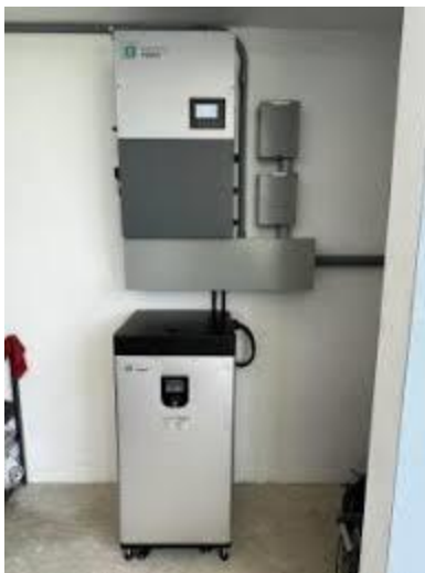
Bateria Fortress eVault con Inversor
