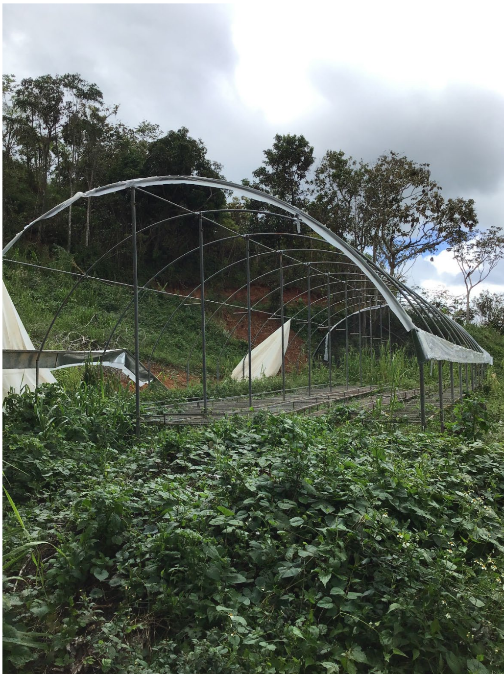
Estructura existente en los terrenos.
