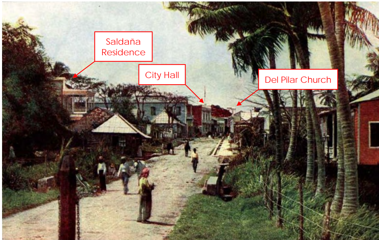
Figure 15. 1898 photograph by Walter Townsend of north entrance to the Río Piedras urban center along the Carretera Central or Travesía de Río Piedras, looking south (Source: Puerto Rico urbano: Atlas histórico de la ciudad puertorriqueña - Vol. III: Entresiglos, 1880-1910, p. 407, Aníbal R. Sepúlveda 2004).
