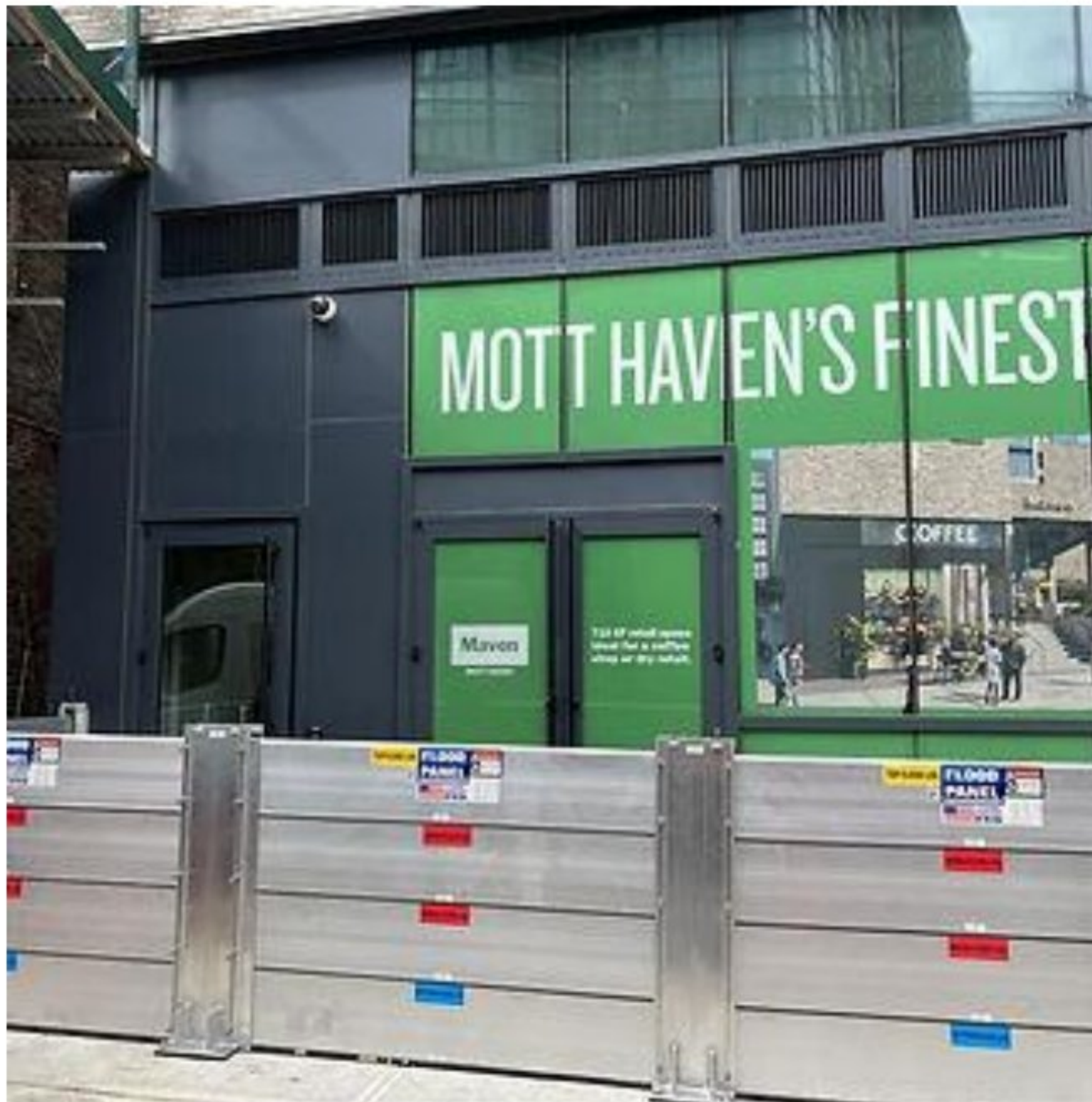
Figura 1: Ejemplo de Instalación de Barreras en Local Comercial
