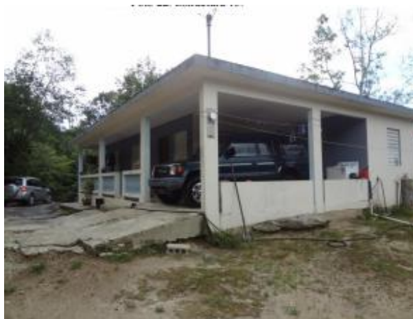
Foto - 5 - FOTO 23 mostrando la ESTRUCTURA 16 del INFORME 2012. (INFORME 2012, pág. 21).
