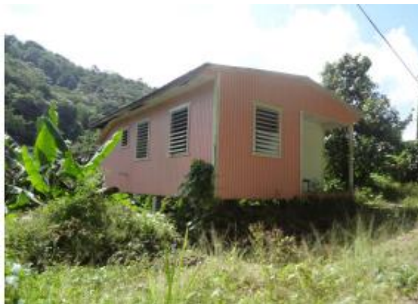
Foto -3- FOTO 10 mostrando la ESTRUCTURA 8 del INFORME 2012. (INFORME 2012, pág. 15).
