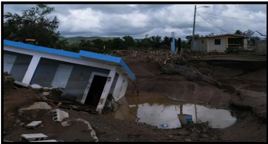
Figura 14: Casa destruida en Salinas, cerca del Río Nigua, Fuente: Gabriella N. Báez/NPR Network
