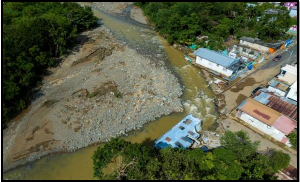
Figura 15: Una casa se derrumbó en un río en Guayama, Fuente: Ricardo Arduengo – Reuters.
