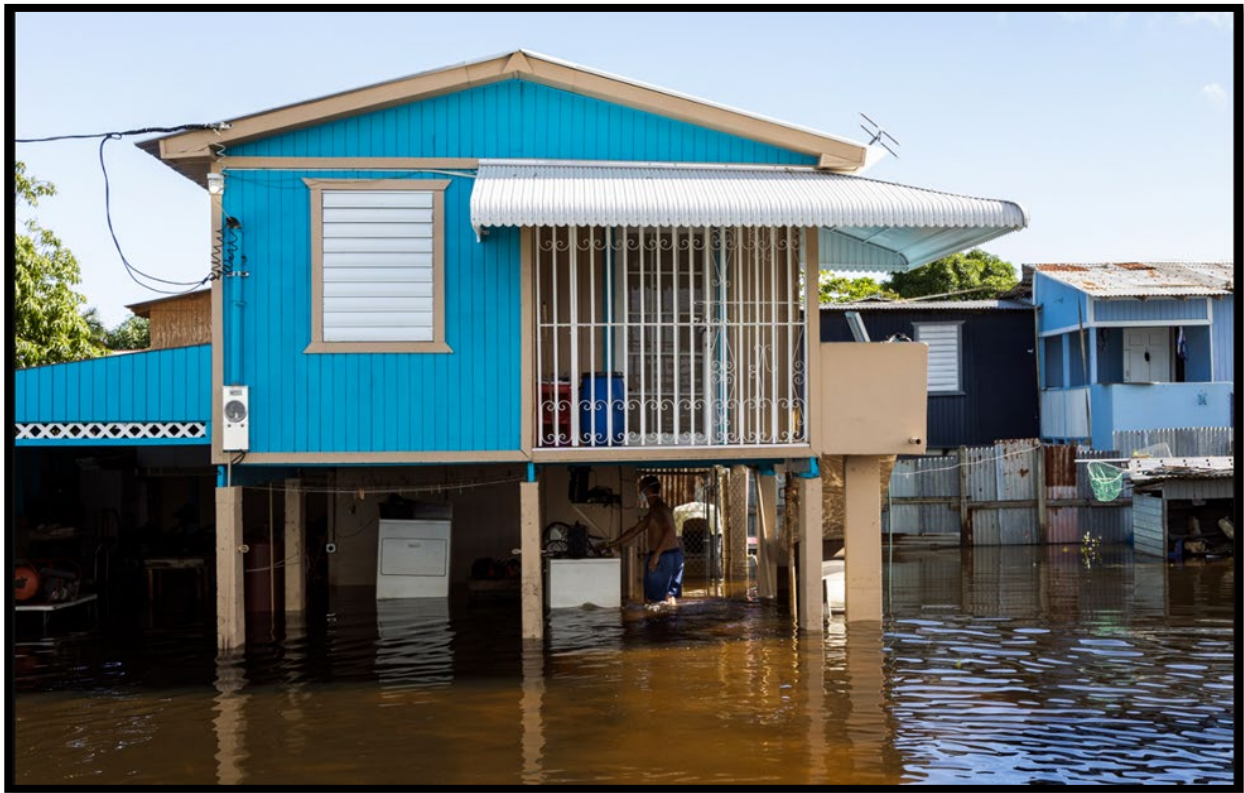
Figura 2: Una casa en la zona inundada del municipio de Cataño, Puerto Rico, 9 de febrero de 2022 22
