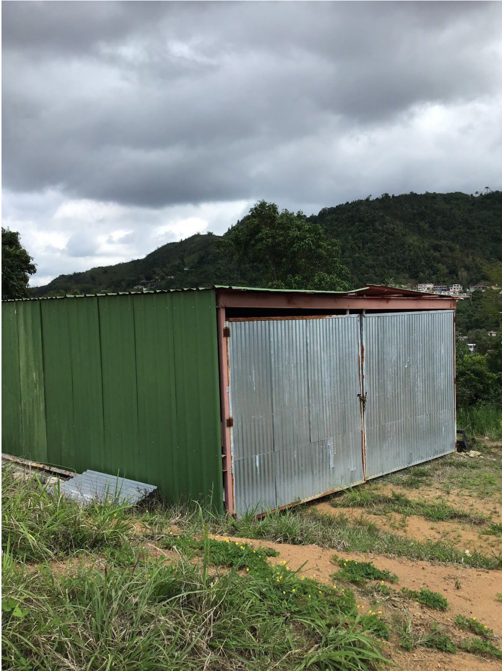
Area para almacenamiento
