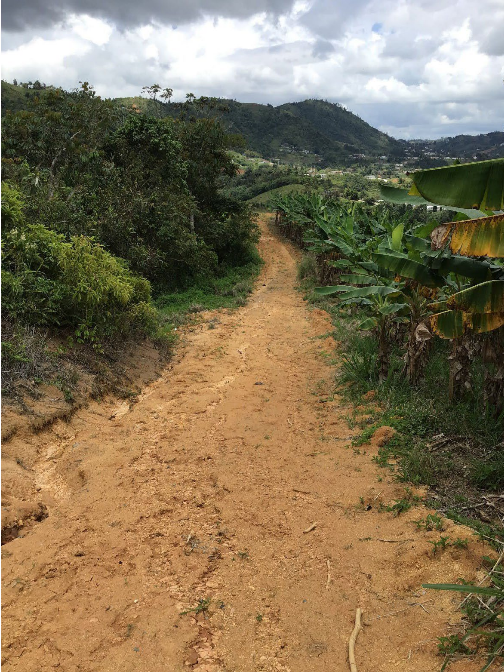
Camino sin control de flujo de agua
