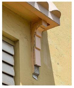
Delaminación del empañetado en detalles arquitectónicos.
