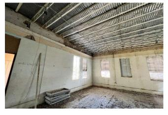
Cubierta de techo reemplazada con formaleta de acero y losa de concreto.
