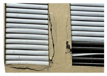
Detalle de grieta debido a la delaminación del hormigón en la fachada Norte, segundo nivel.
