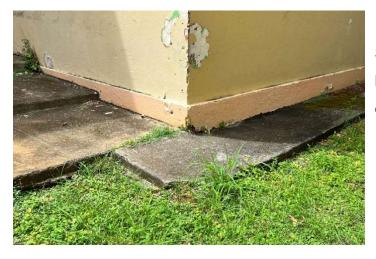
Se observa asentamiento en las losas sobre tierra en el perímetro del edificio.
