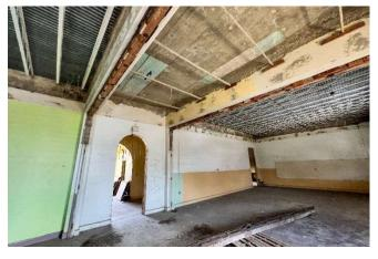
Remplazo de losa de techo con losa de hormigón y cubierta de metal.
