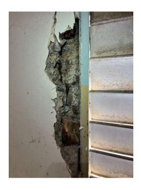
Detalle de corrosión del refuerzo en las columnas del segundo nivel.
