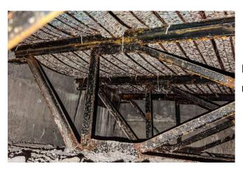
Detalle de tijerilla de acero y malla de refuerzo de la losa del segundo nivel.
