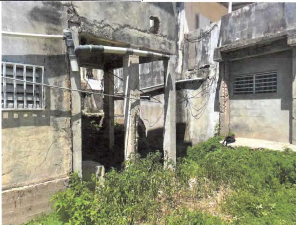
Foto #33 Vista de expansión y construcciones adosadas
