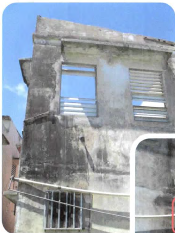
VISTAS DE LA NAVE DEL NIVEL SEGUNDO
