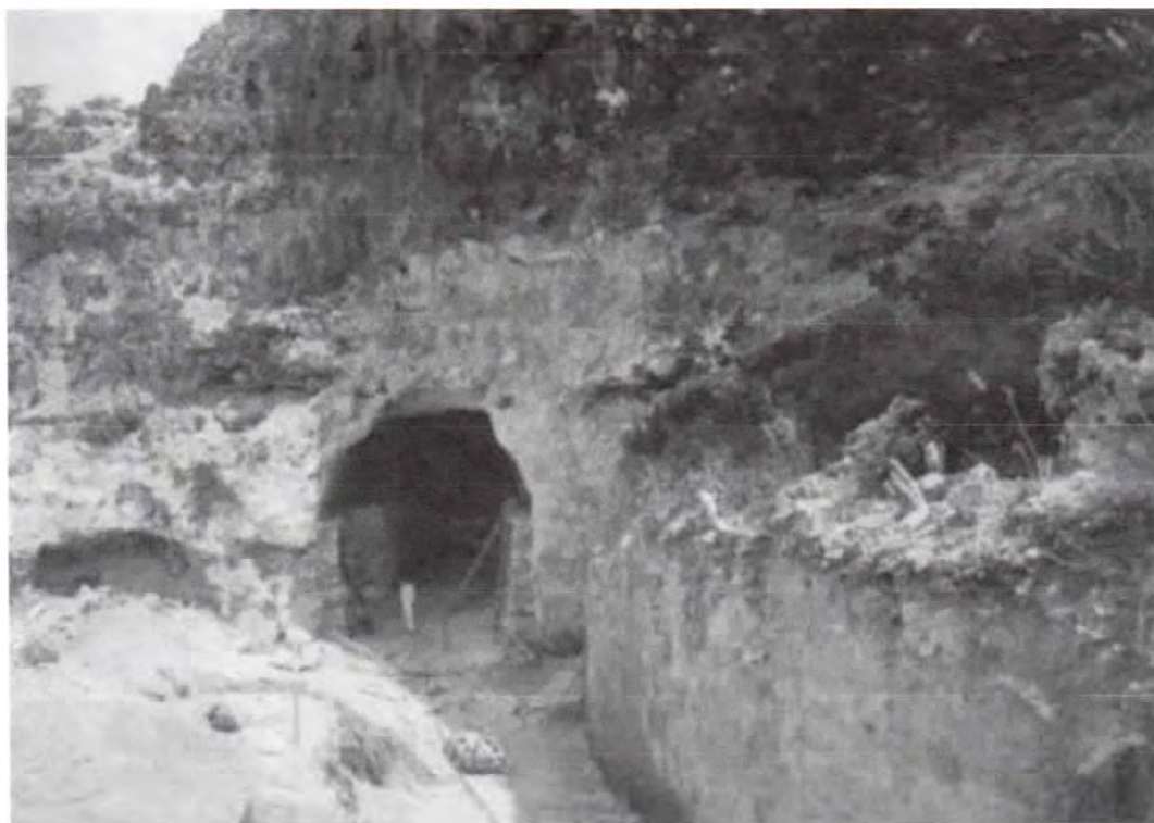
Foto #24 Construcción Túnel de Guajataca ca. 1917 Autor Moscioni, A.
