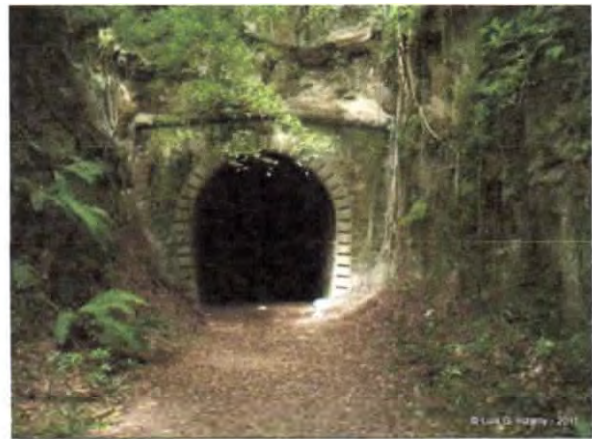
Foto # 22 Túnel de Quebradillas o Túnel Negro QB0200012
