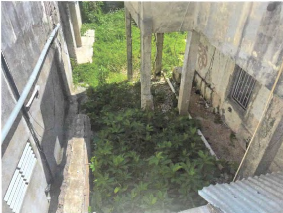
Foto #29 Vista de la parte posterior del edificio
