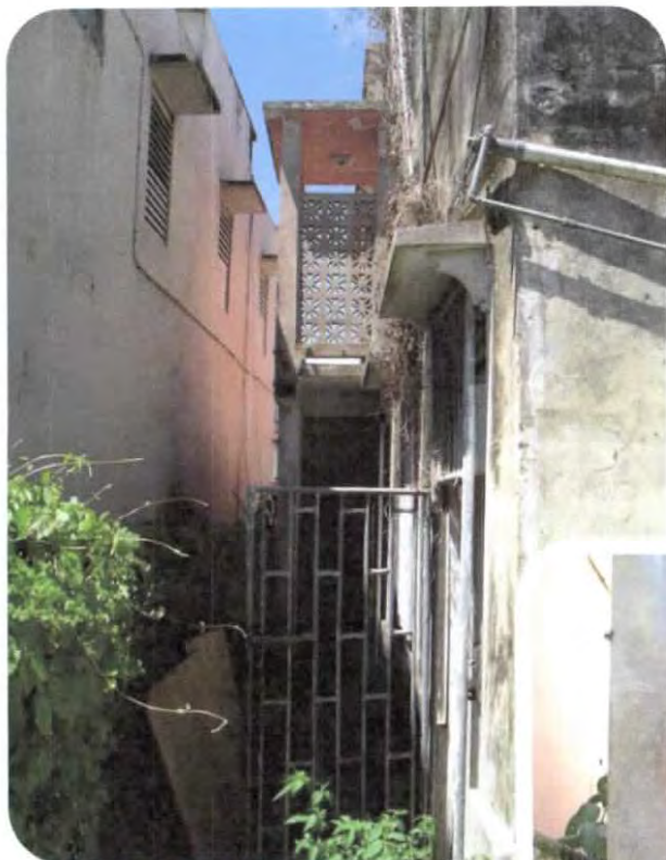
ÁREA DE PATIO LATERAL, ENTRE EDIFICIOS Y EN EL CUAL SE UBICA LA ESCALERA
