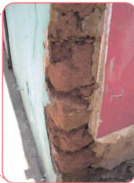
DETALLE DE ESQUINA EXPUESTA EN LA QUE SE APRECIA CONSTRUCCIÓN DE LADRILLO CON JUNTAS DE MORTERO A BASE DE CAL Y ARENA
