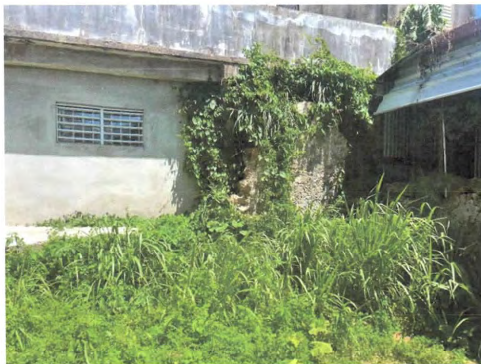
Foto #32 Vista de pared aledaña construida en piedra caliza
