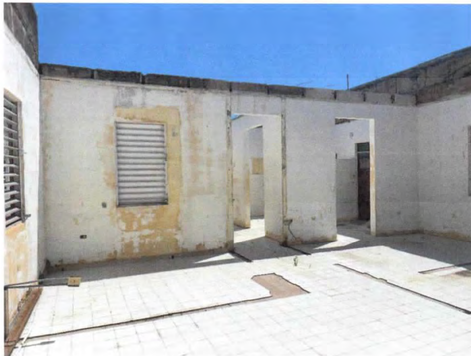
Foto #27 Vista del interior del edificio
