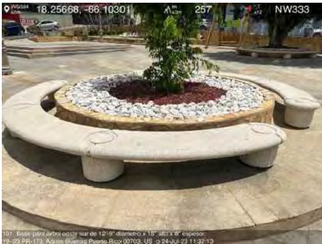
107. Base para árbol oeste sur de 12'-0" diámetro x 1'8" alto x 8" espesor. 19-23 PR-173, Aguas Buenas Puerto Rico 00709, US - 24-Jul-23 11:22:13
