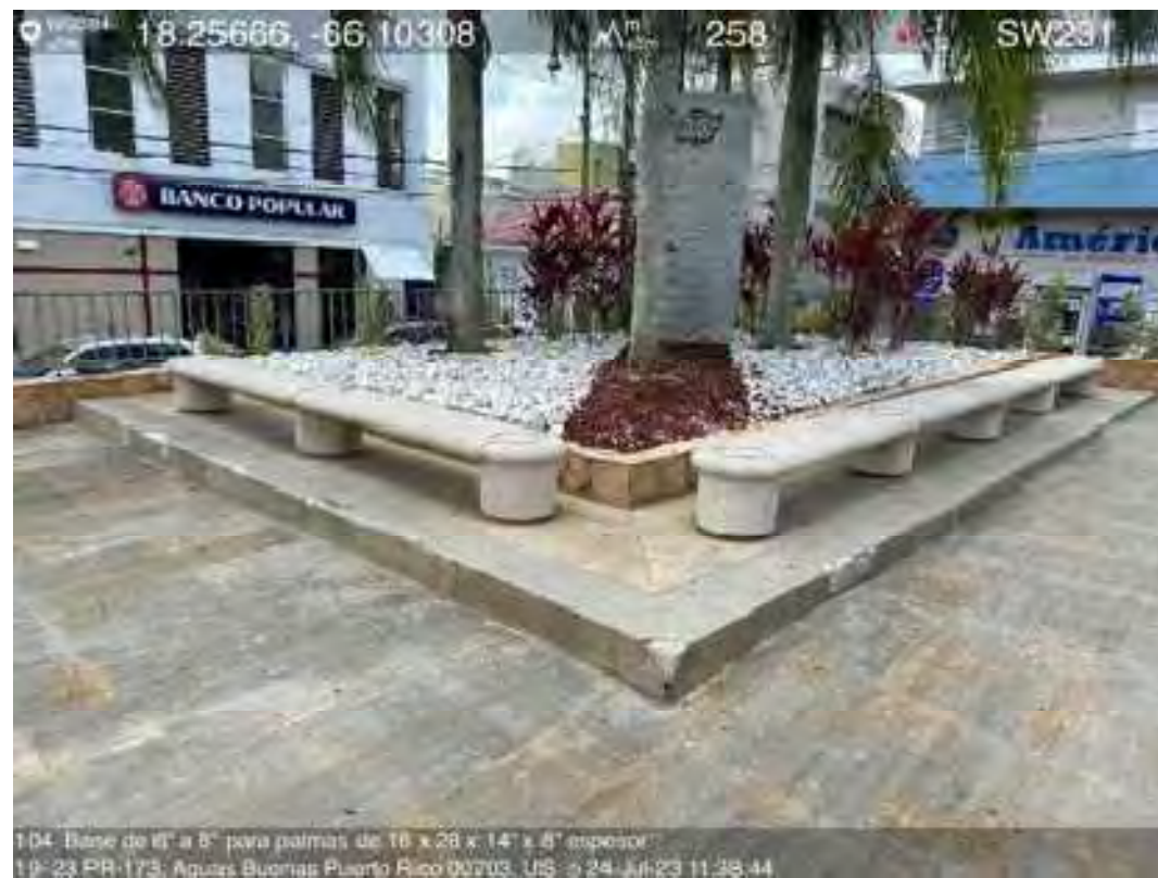
104. Base de 6" x 8" para palmas de 16' x 14' x 1'8" espesor. 19-23 PR-173, Aguas Buenas Puerto Rico 00709, US - 24-Jul-23 11:23:44
