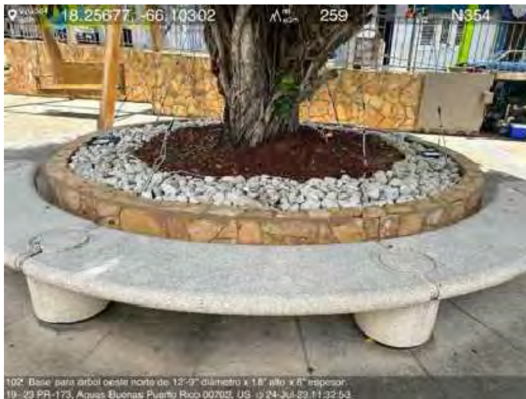
109. Base para árbol oeste norte de 12'-0" diámetro x 1'8" alto x 8" espesor. 19-23 PR-173, Aguas Buenas Puerto Rico 00709, US - 24-Jul-23 11:22:51
