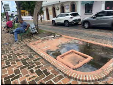
IMAGEN 7: Remover cemento para restituir áreas de siembra. Tola de acera permanece.
