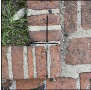
IMAGEN 11: Evitar cortes que afecten los materiales existentes.
