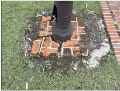
IMAGEN 1, 2 y 3 : Reparar bases de postes a su forma original con ladrillos. Demoler y remover exceso de cemento alrededor.
