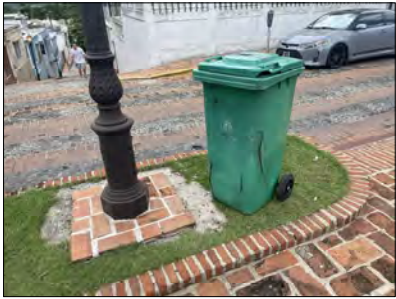
IMAGEN 1, 2 y 3 : Reparar bases de postes a su forma original con ladrillos. Demoler y remover exceso de cemento alrededor.
