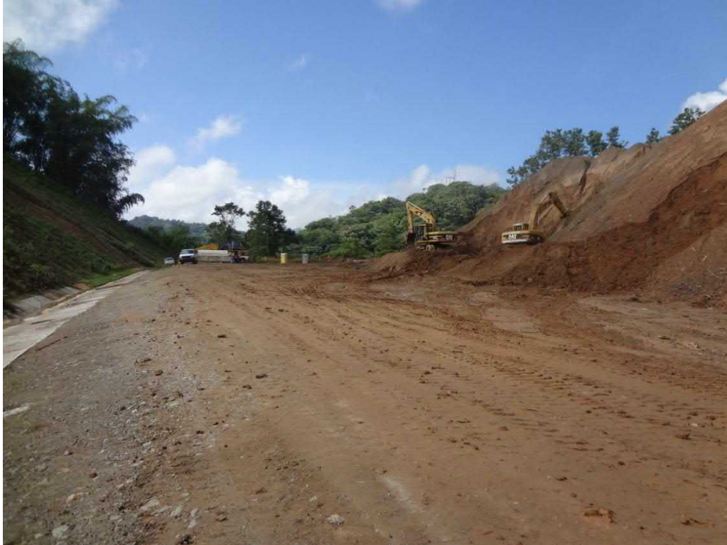
Foto 2. Área donde se encontraban las estructuras 1-3.
