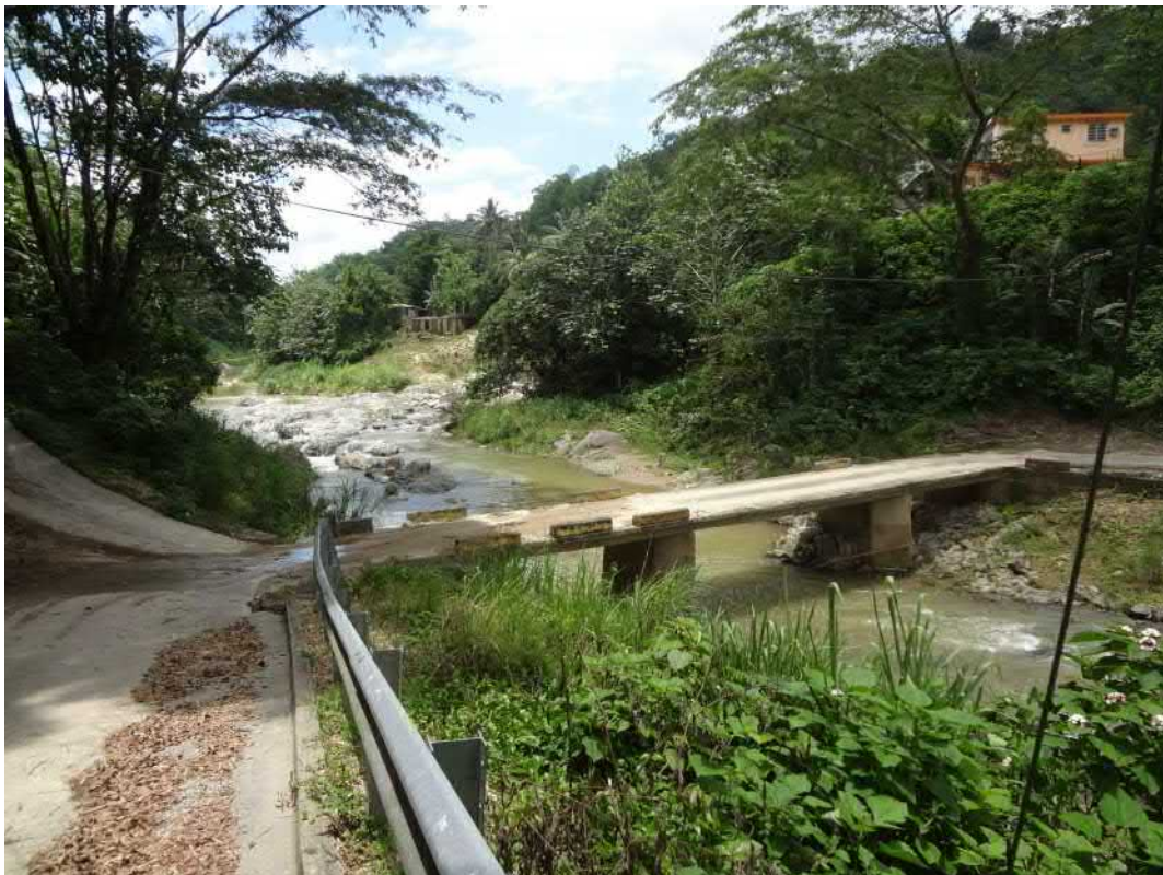
Foto 5. Actual puente sobre el río que se toma para llegar al área de proyecto.
