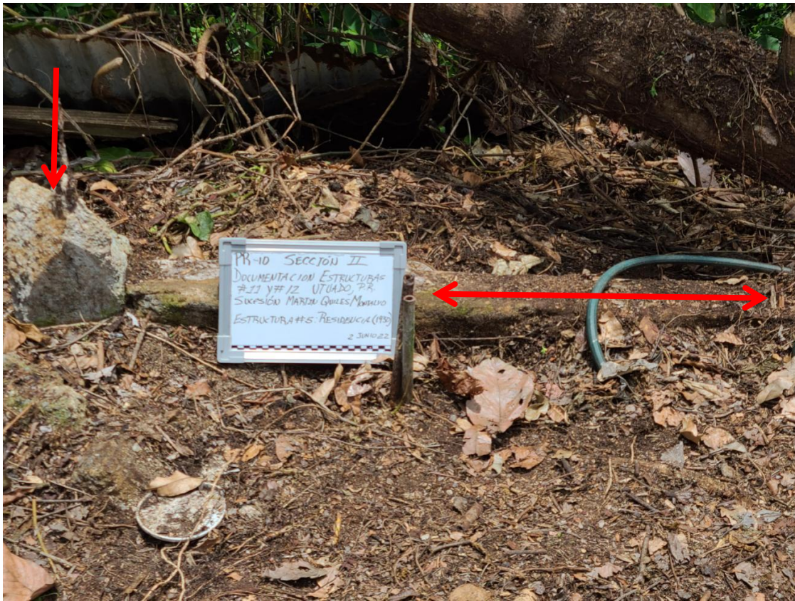
Foto - 50- Muro de contención y remanente de uno de los socos, ambos contruidos de hormigón y varillas modernas. Obsérvese la tubería galvanizada conductora de agua potable en lo que fuese el área de la cocina, según informado por el señor Quiles López. (Archivo Arqla. Virginia Rivera Calderón).
