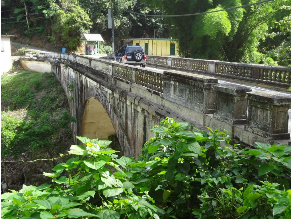
Foto 4. Puente Blanco, localizado en la carretera PR-123 Km. 48.1.
