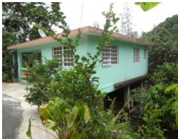
Foto -1- FOTO 31 mostrando la ESTRUCTURA 22 del INFORME 2012. (INFORME 2012, pág. 25).
