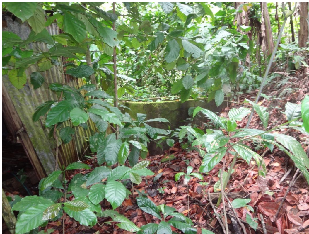
Foto -39- FOTO 18 del INFORME 2012, página 19, mostrando a la izquierda parte de la pared frontal del almacén del nivel superior (actualmente inexistente) (ESTRUCTURA 12) y al fondo otra estructura aledaña. (INFORME 2012).
