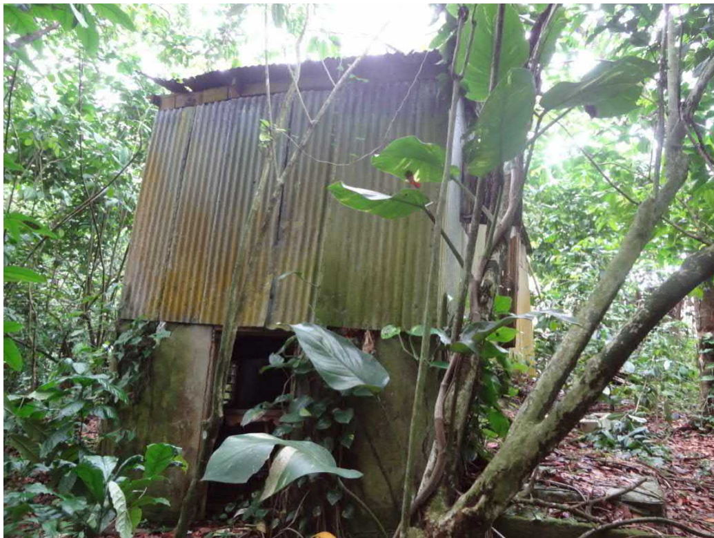
Foto 15. Vista lateral de la estructura 12.
