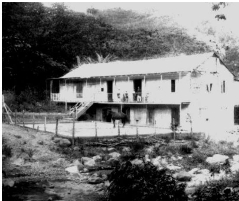
Foto -13- Hacienda cafetalera en el Municipio de Maricao, exponiendo en primer plano la estructura construida en hormigón a manera de un piso conocido como "el grásil", en este caso verjado. (Grupo Editorial EPR, EL CAFÉ EN EL SIGLO XIX, Enciclopedia pr.org, adaptación del artículo MARICAO Y SUS HACIENDAS CAFETALERAS, ICP, 2014 ).
