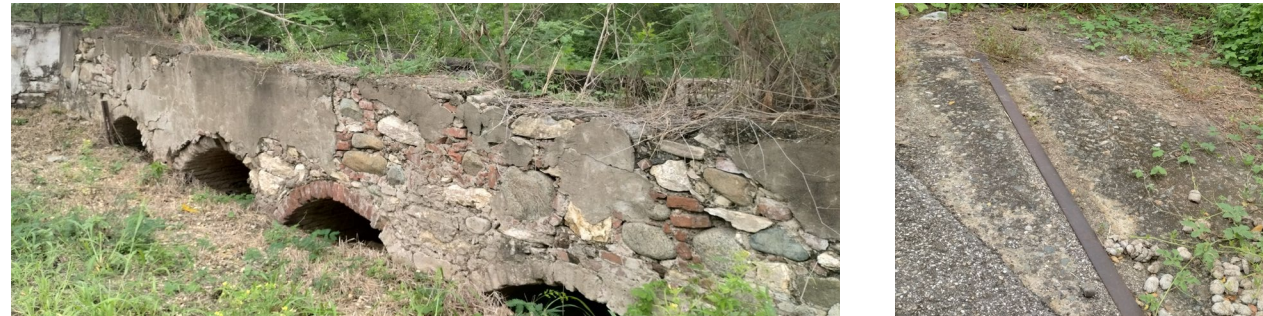
Figura 36: Antiguo canal de riego de la “Comunidad de Regantes del río Jacaguas” (derecha) y restos de las vías de ferrocarril del ramal hacia la Central Fortuna (izquierda).
