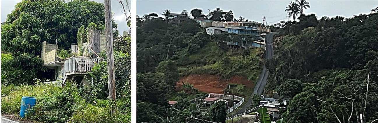
Figura 36: Viviendas abandonadas (imagen izquierda) y ubicadas en áreas susceptibles de deslizamientos de tierra (imagen derecha) en Montes Llanos.
