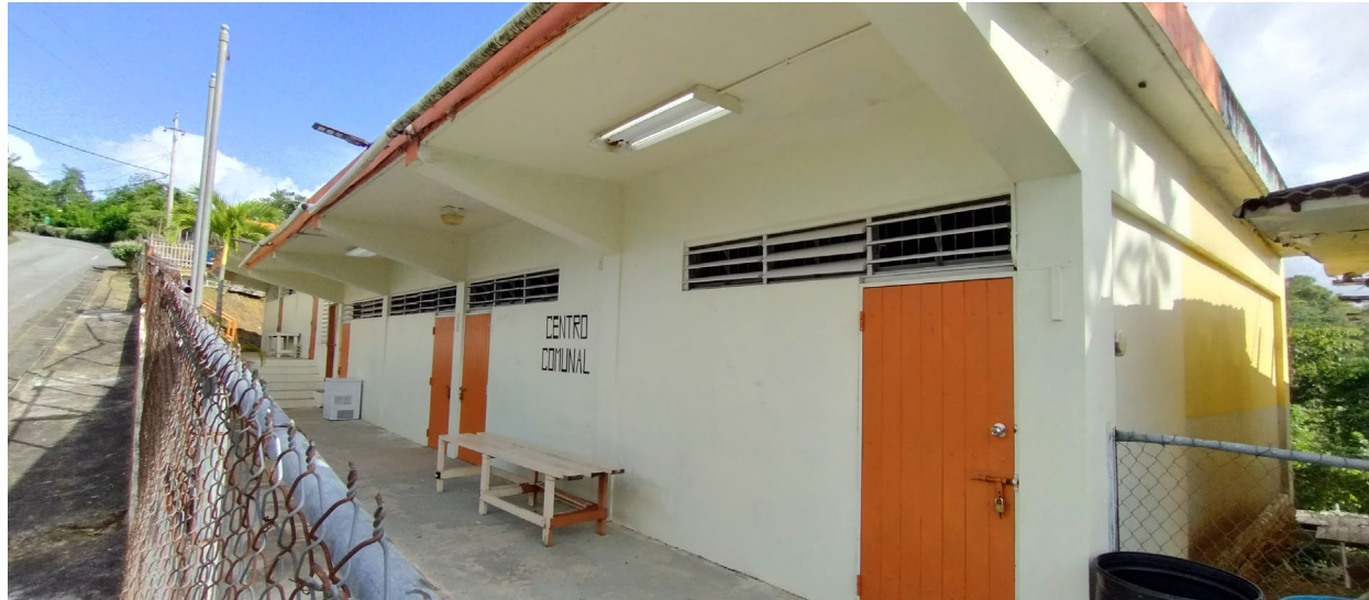
Figura 41: Centro comunal de Montes Llanos.
