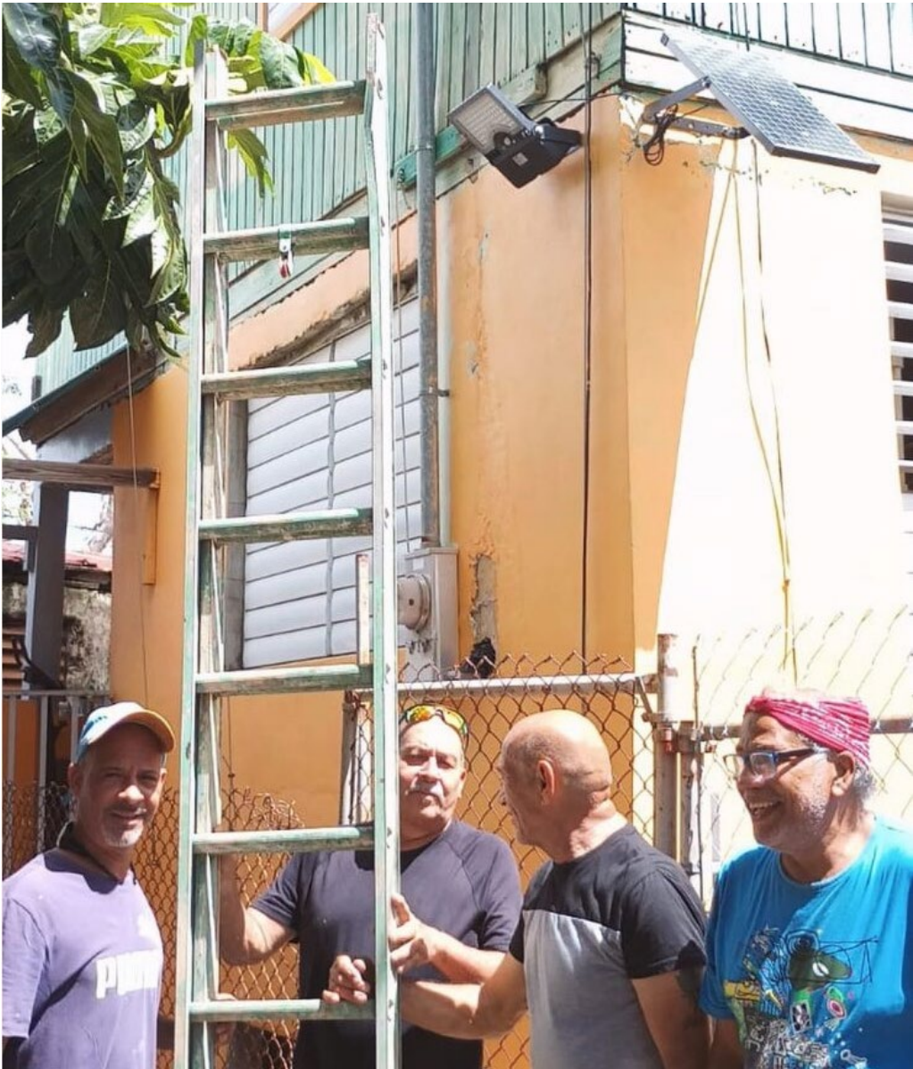
Figura 48: Instalación de focos solares.
