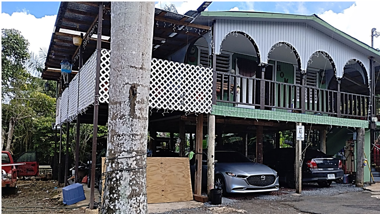
Figura 38: Ejemplo de vivienda con materiales combinados (hormigón, madera y zinc) en Juan Asencio.
