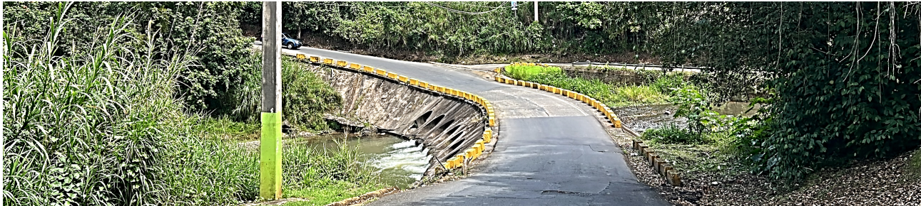
Figura 28: Acceso a la comunidad Juan Asencio, desde el casco urbano de Aguas Buenas, a través del Puente La Charca en el ramal 790 de la carretera PR-174.
