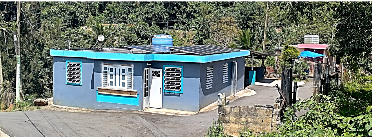
Figura 41: Ejemplo de vivienda con techo y paredes de hormigón en Juan Asencio.
