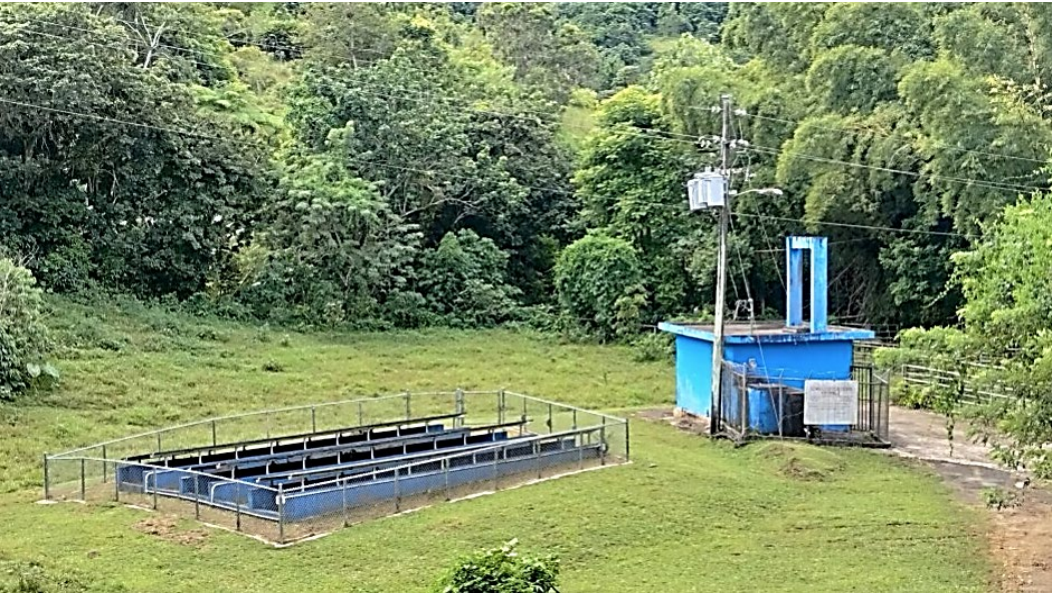
Figura 52: Acueductos con energía renovable
