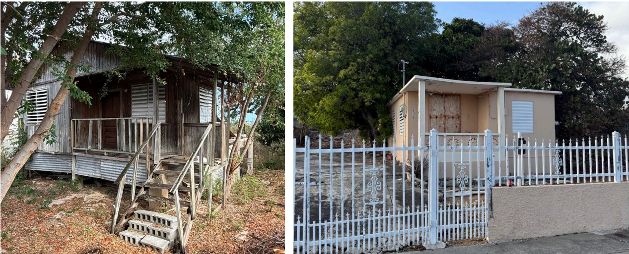
Figura 33: Viviendas abandonadas en la comunidad El Tuque
