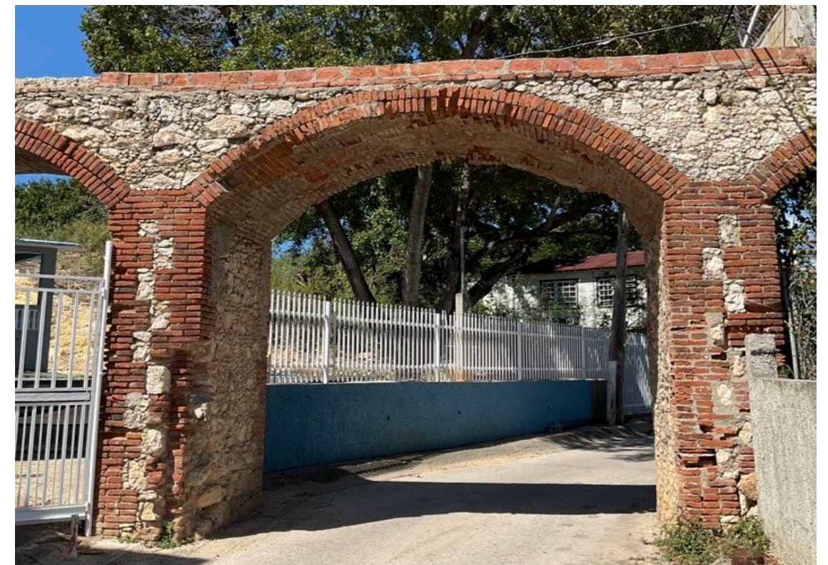
Figura 9: “Acueducto Español”, una infraestructura de riego del siglo XIX ubicada en la comunidad El Tuque.
