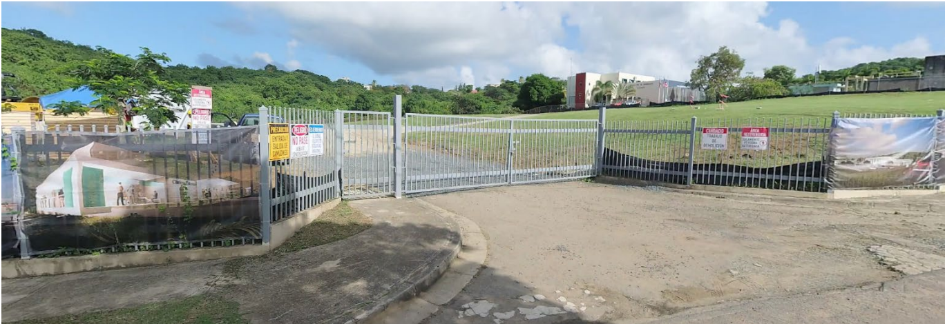
Figura 35: Proceso de construcción del CDT Susana Centeno
