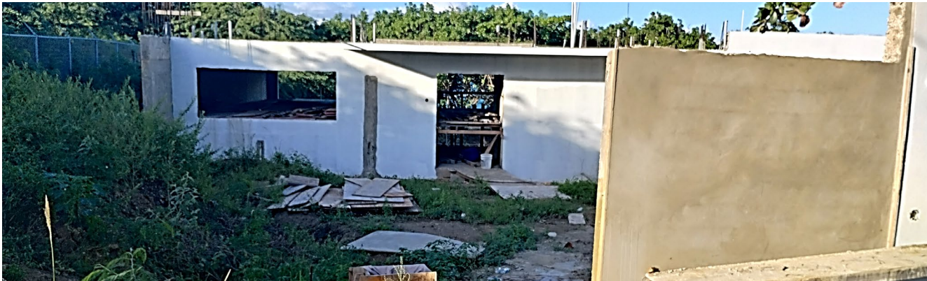
Figura 19: Vivienda en construcción en el sector Bastimento de Villa Borinquen.
