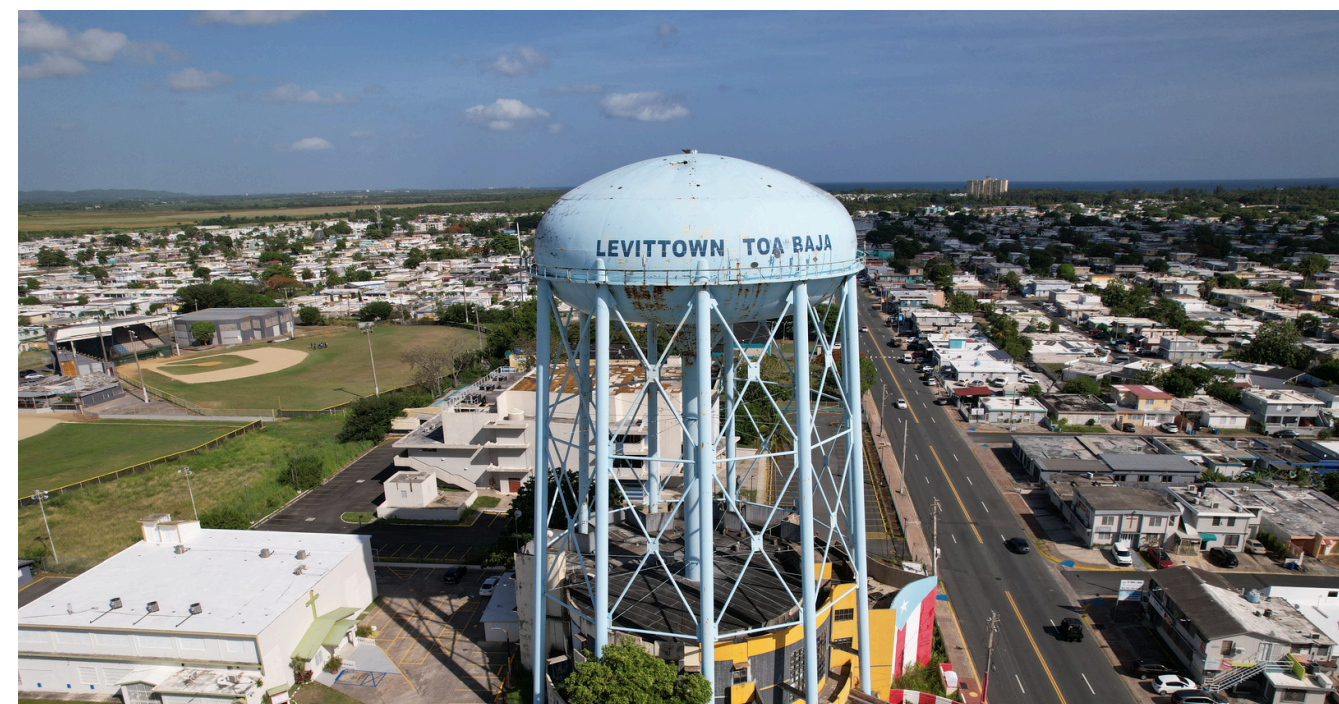
Ilustración 13: Tanque de Agua, ubicado en la Avenida Boulevard en Levittown, Toa Baja
