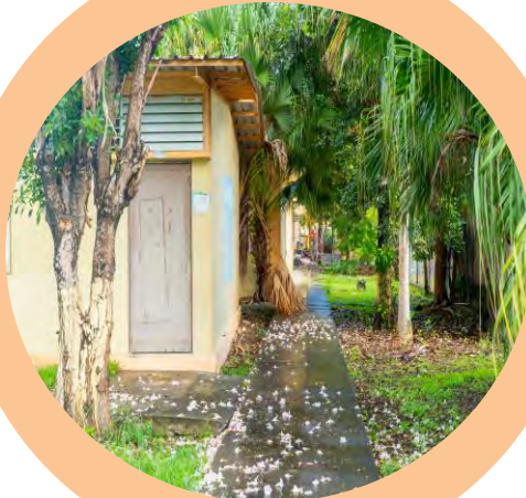
Foto 17: Escuela y punto de encuentro por tsunami
