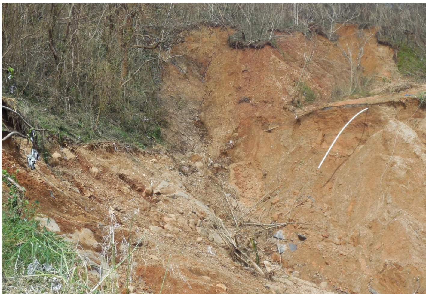
Vegetación y suelo afectados por el huracán María. Foto provista por el municipio de Barranquitas (s.f.).
