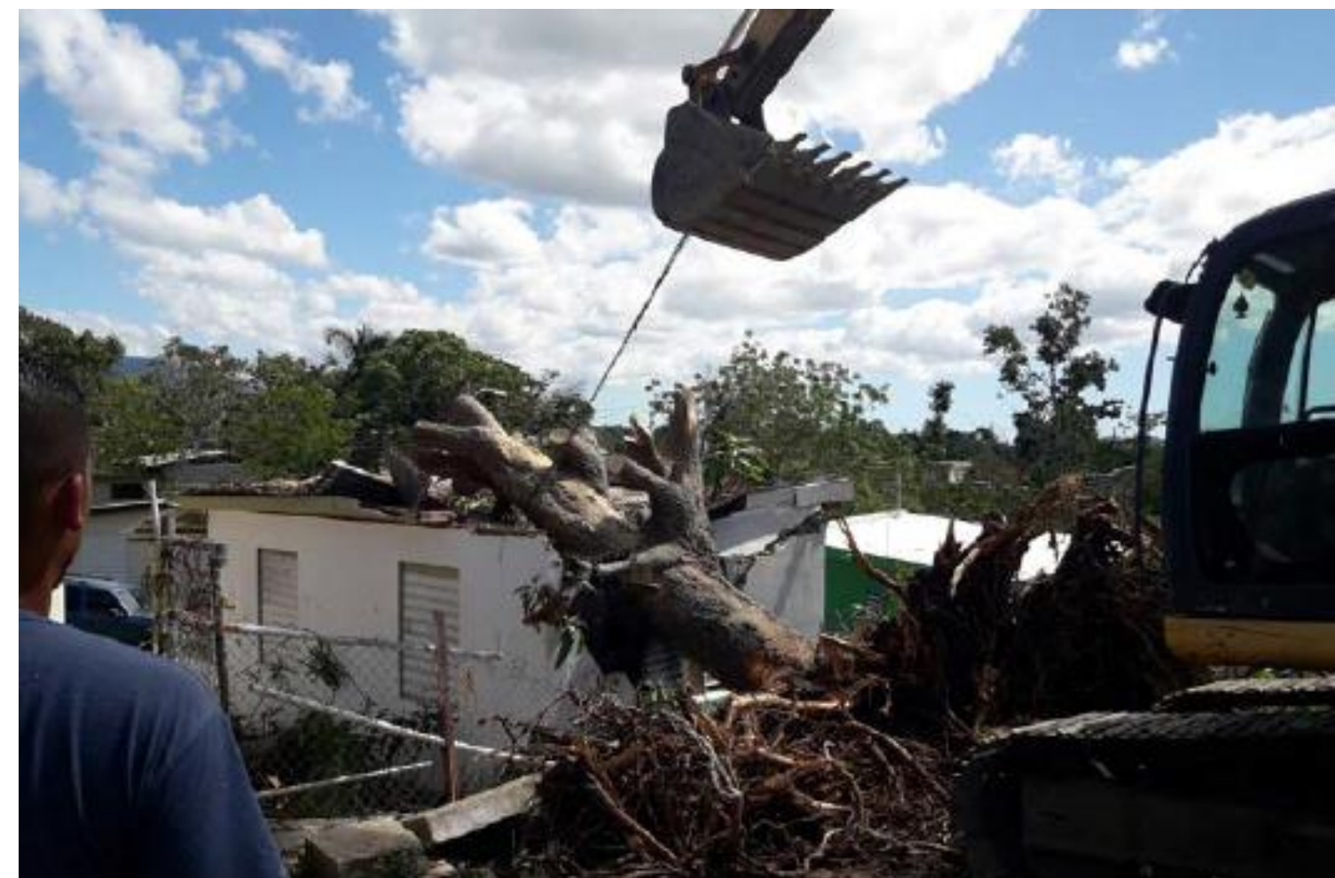
Brigada municipal con equipo pesado removiendo escombros en área residencial. Foto del municipio de Hormigueros, 2017.
