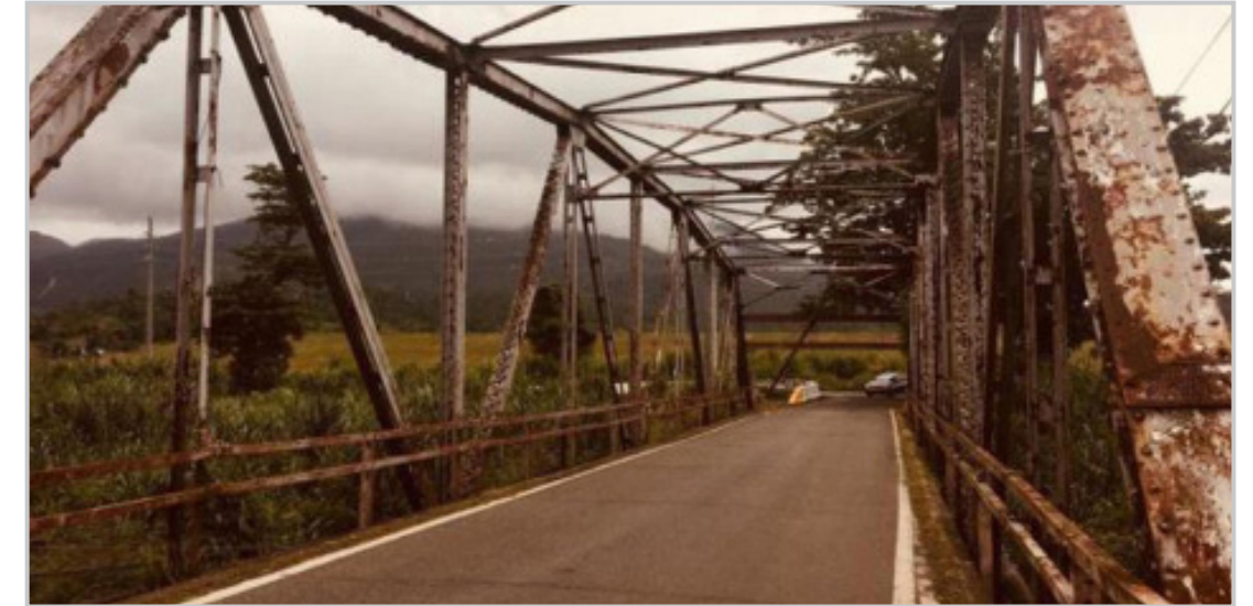
Ilustración 60. Puente entrada Cubuy y Ruta Panorámica carretera PR 191
